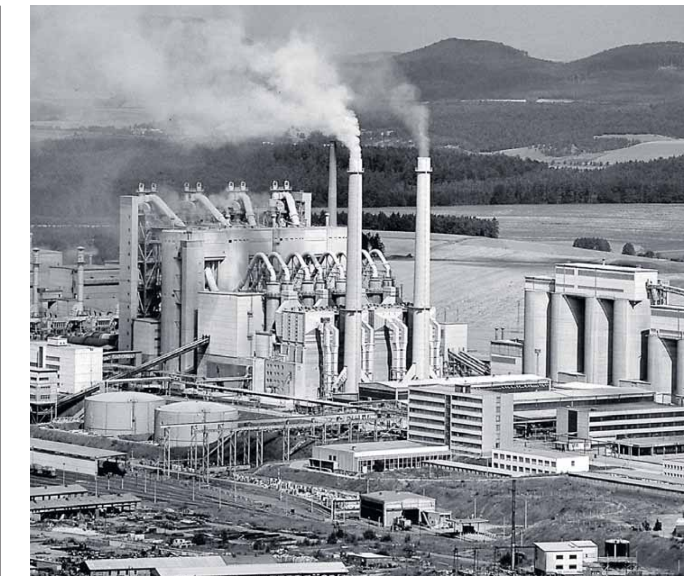
Läuft seit 1975: einst VEB Eichsfelder Zementwerk Deuna, heute Deuna Zement GmbH.
